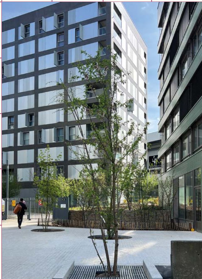
Aménagement et plantation des abords des lots 4.2E et 4.2F
