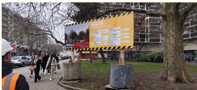
Chantier Tournai Delory
