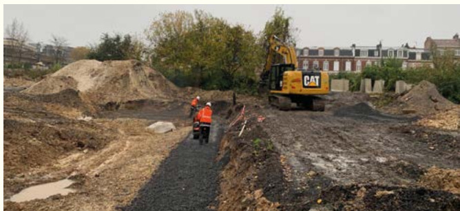
Chantier parc Saint Sauveur
