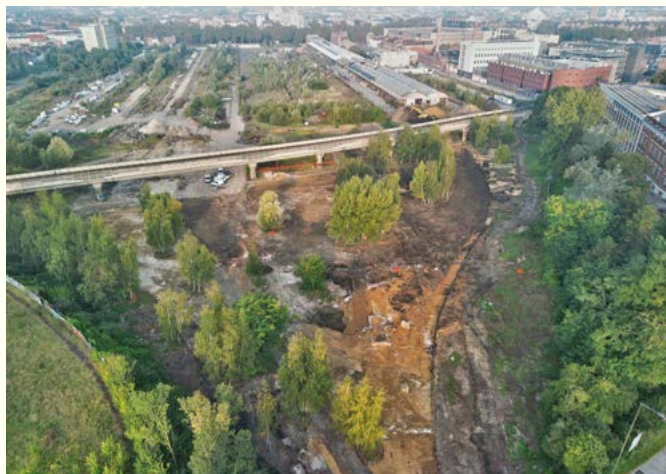
Chantier parc Saint Sauveur
