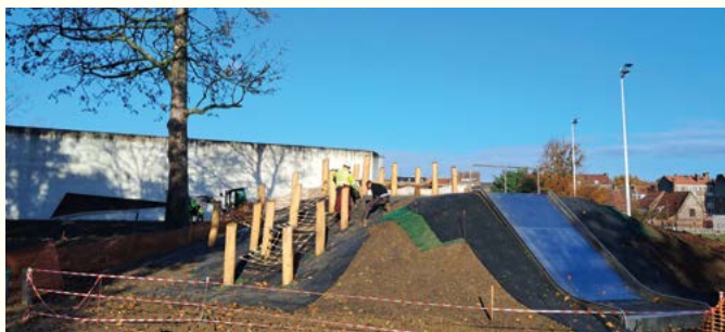
Chantier square Concorde
