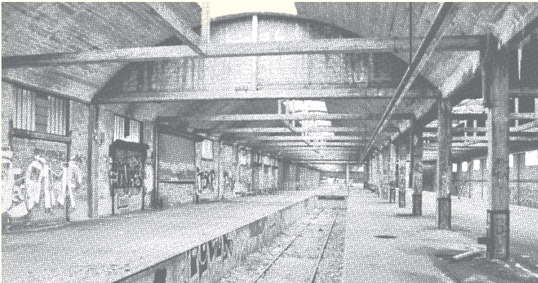
L'intérieur des halles : hier le bruit des déchargements et des trains, aujourd'hui le murmure du vent et des graffs.
