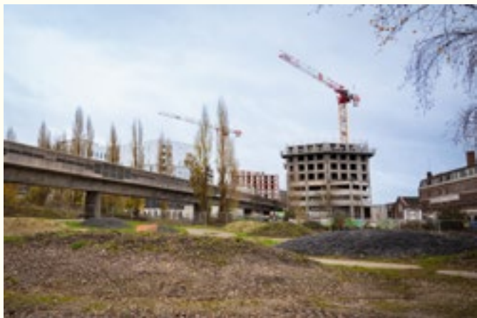
Saint-Sauveur et Pepinière - Chantier du Parc et du Lot 5.4 © Claire-Marie Régent
