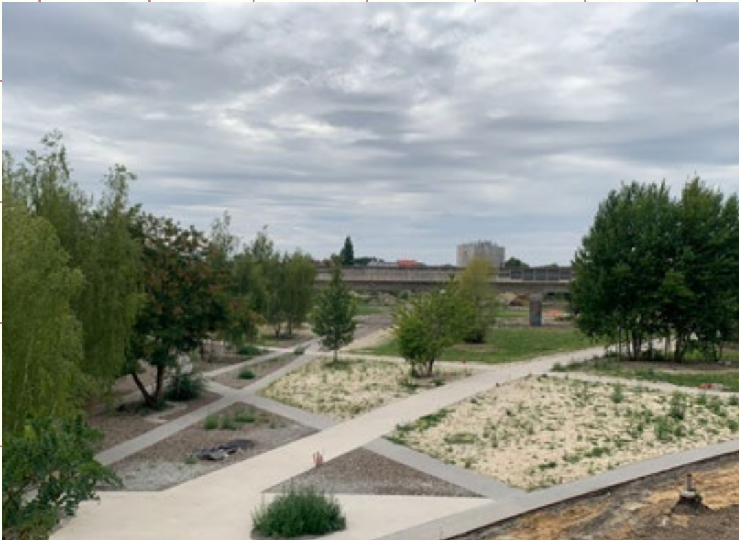
Chantier du parc Saint-Sauveur
