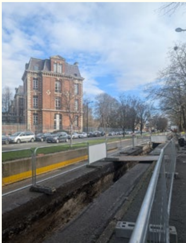
Préviabilisation du Boulevard de Metz
