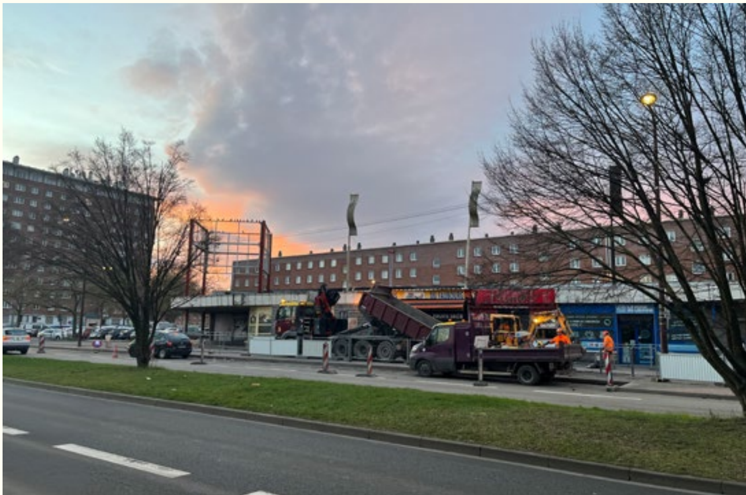
Préviabilisation du Boulevard de Metz
