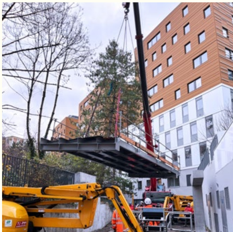
Pose de la passerelle ouest - Parc Germaine Tillion
