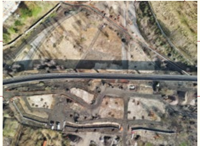
Chantier du parc Saint-Sauveur © MEL
